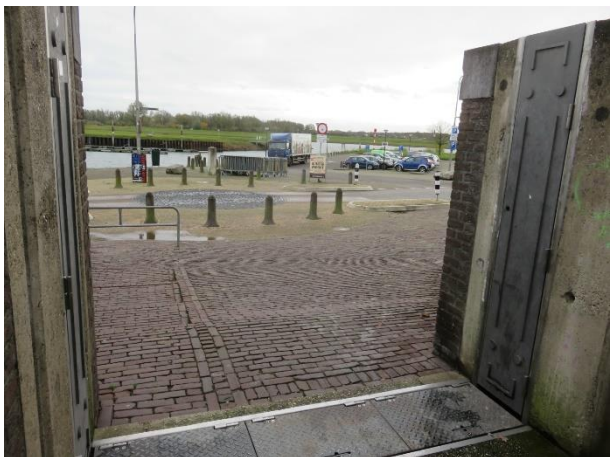
De doorgang die bij hoog water aan weerszijden wordt afgesloten met planken waarbij de tussenliggende ruimte dan wordt volgestort met zand. Op de achtergrond de genoemde parkeerplaats. De hoogste waterstand ooit hebben we beleefd in 1988. Toen bereikte het water aan de buitenkant van de muur de hoogte van 1.80 m (!)
