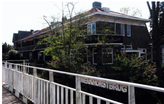
De huizen rechts over de Werkhorstbrug. (Foto Rudi ter Heide)
